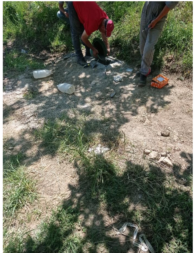
Figura 29: Inserimento nella parte alta del foro di malta cementizia per cementare l'ancora superiore
