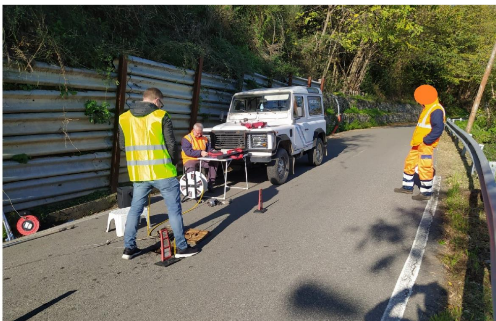
Figura 3: Misure nel foro di sondaggio S1
