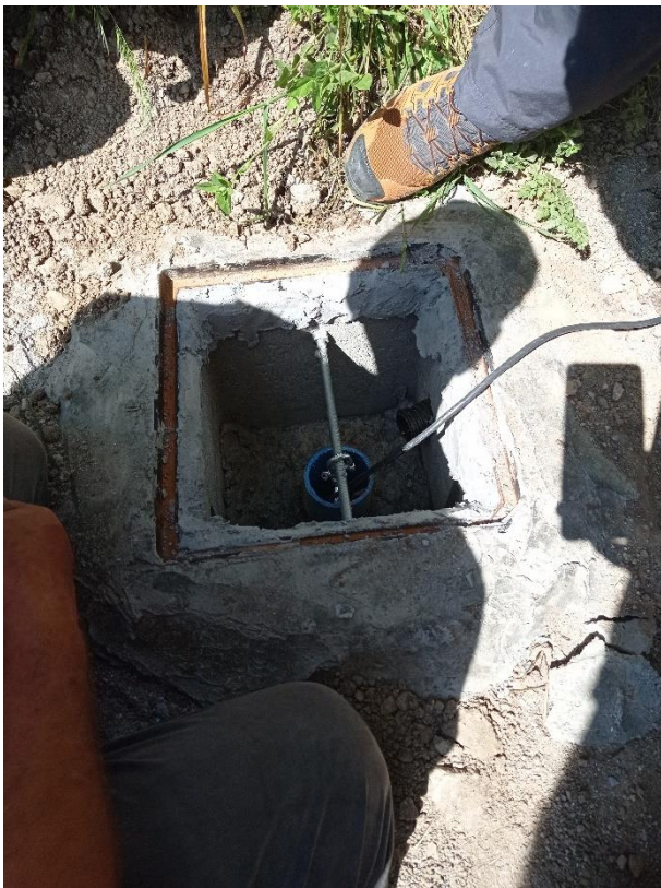
Figura 20: Ancoraggio superiore della catena
