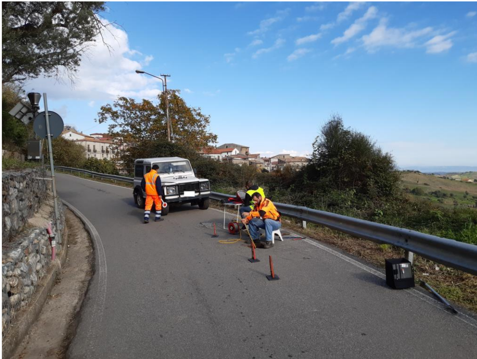
Figura 8: Misure nel foro di sondaggio S2
