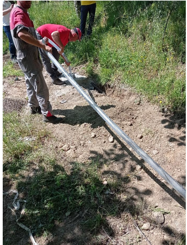
Figura 19: Inserimento della catena nel foro
