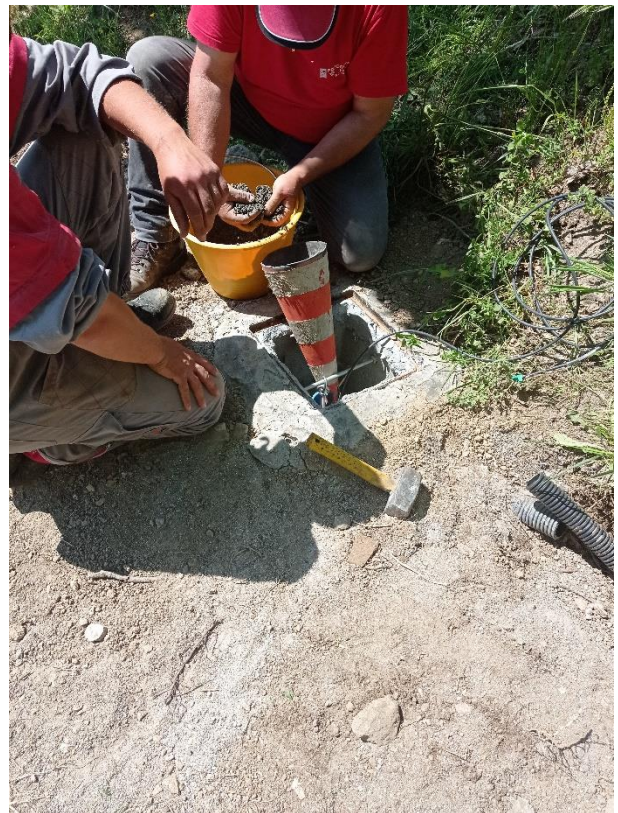
Figura 21: Inserimento in foro di malta cementizia per cementare l'ancora inferiore
