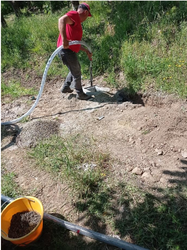
Figura 18: Fissaggio dell'ancora alla catena
