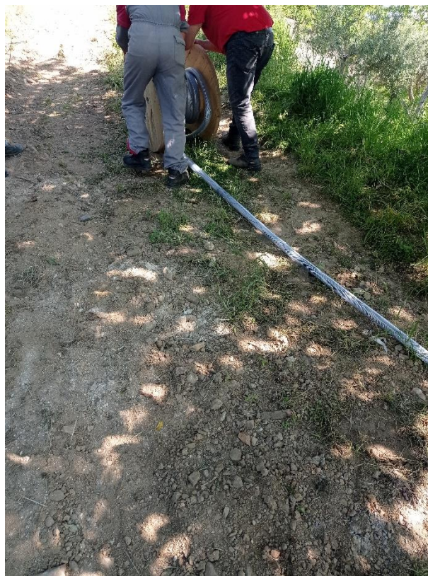
Figura 17: Srotolamento della catena inclinometrica
