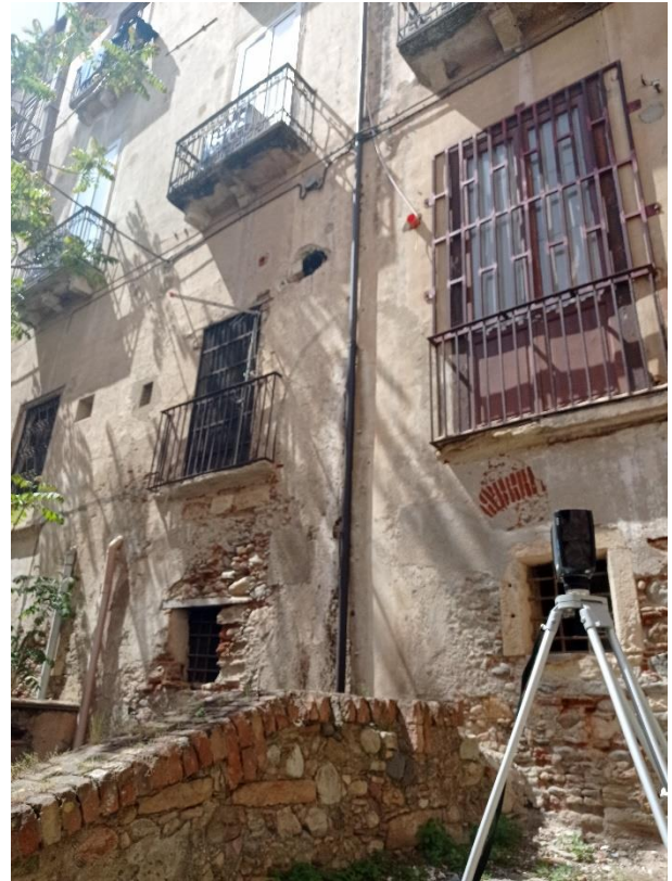
Figura 8: Rilievo al punto 3
