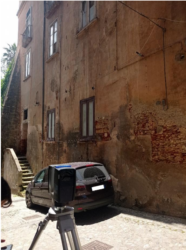
Figura 11: Rilievo al punto 5
