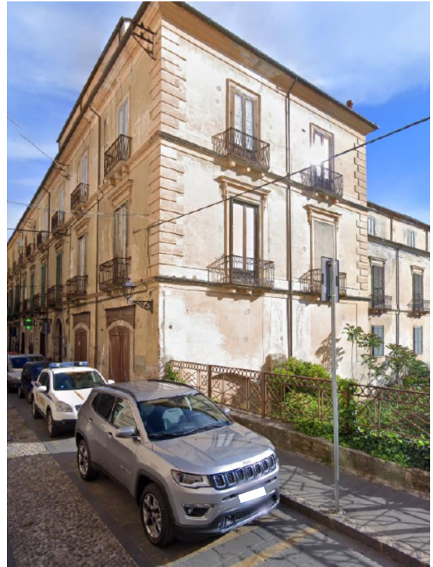
Figura 11: Rilievo al punto 6
