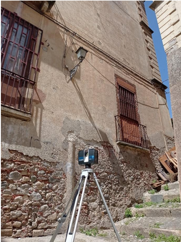
Figura 7: Rilievo al punto 3
