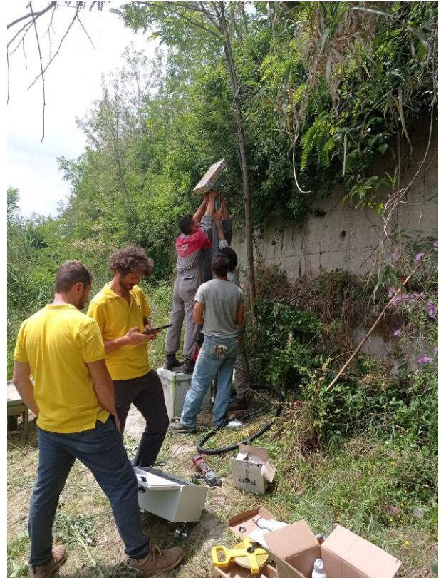
Figura 15: Test dei sensori in sede
