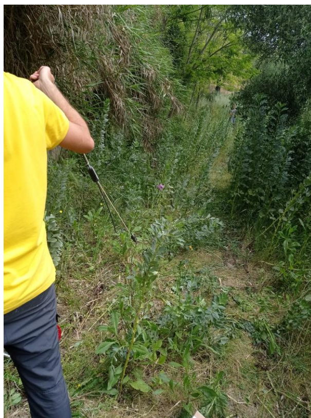
Figura 9: Srotolamento della catena inclinometrica
