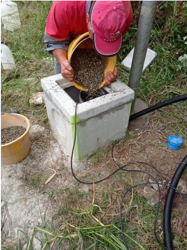
Figura 14: Inserimento di ghiaia per tutta la lunghezza del foro per stabilizzare i sensori
