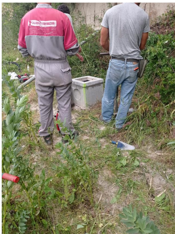
Figura 8: Verifica che il foro fosse vuoto e privo di impedimenti
