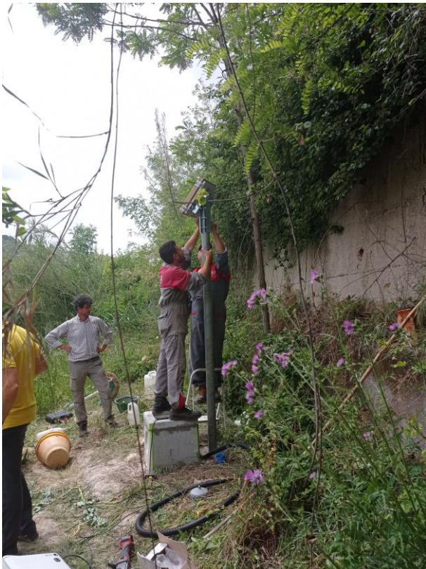
Figura 16: Installazione del pannello fotovoltaico
