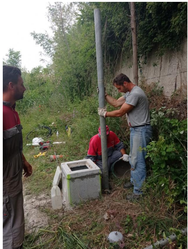
Figura 7: Installazione del palo e la posa della malta cementizia
