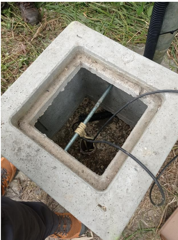
Figura 12: Ancoraggio superiore della catena
