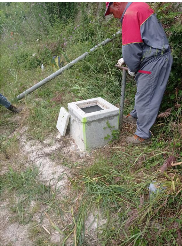
Figura 6: Realizzazione del foro per l'installazione del palo, effettuato con una trivella manuale
