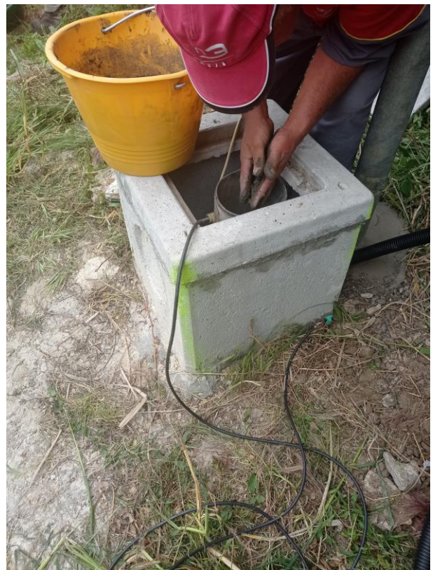
Figura 13: Inserimento in foro di malta cementizia per cementare l'ancora inferiore
