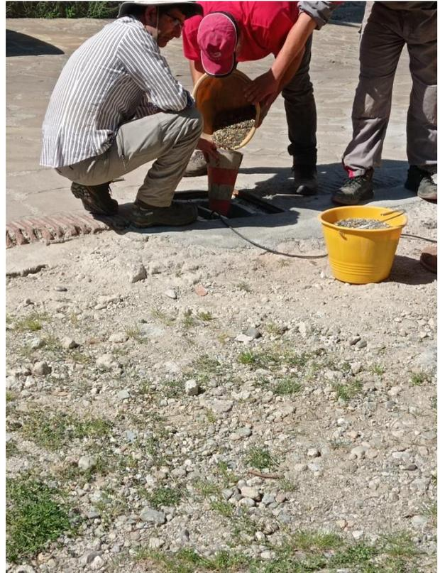
*Figura 17: Inserimento di ghiaia per tutta la lunghezza del foro per stabilizzare i sensori*
