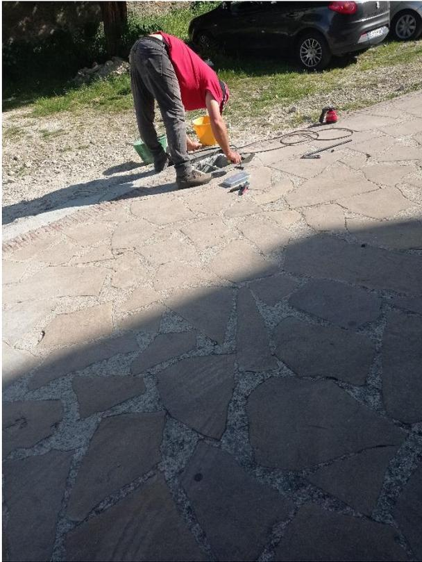
*Figura 24: Inserimento nella parte alta del foro di malta cementizia per cementare l'ancora superiore*
