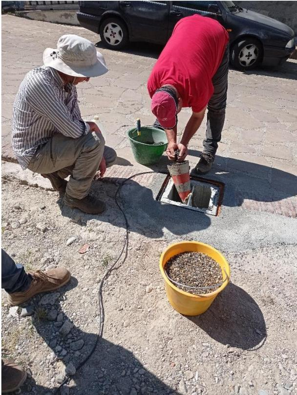
*Figura 16: Inserimento in foro di malta cementizia per cementare l'ancora inferiore*
