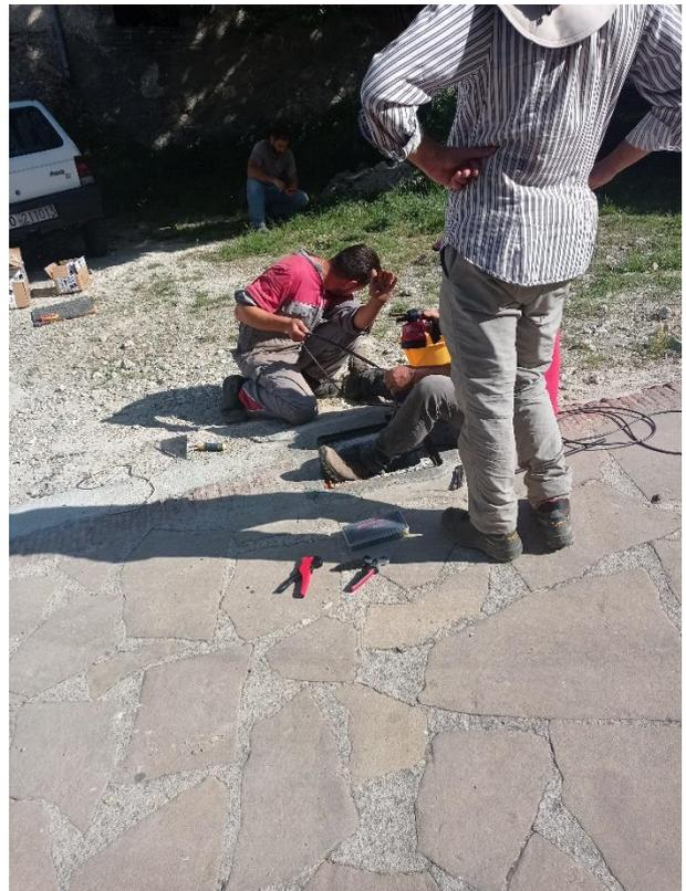
*Figura 19: Passaggio dei cavi all'interno del corrugato*
