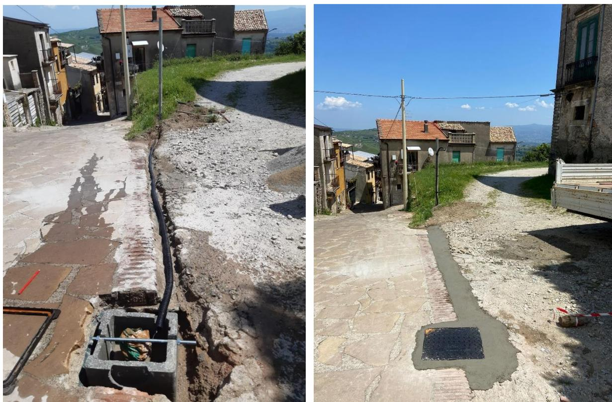
*Figura 9: Modifica del pozzetto, predisposizione del corrugato e del palo*
