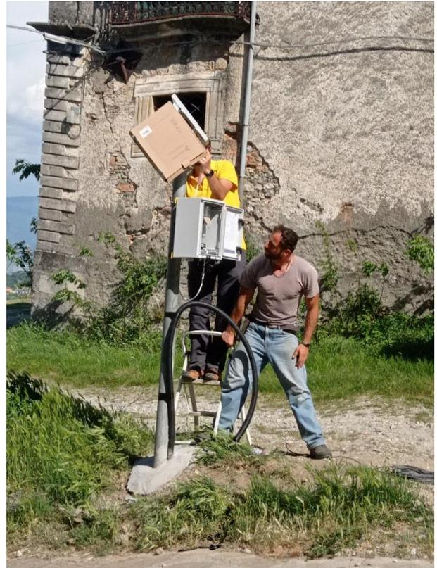
*Figura 21: Installazione della centralina*
