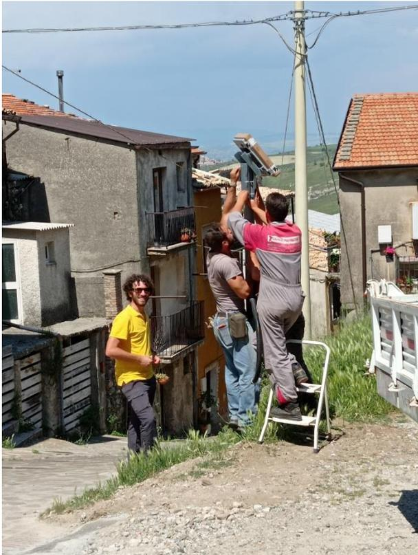
*Figura 20: Installazione del pannello fotovoltaico*
