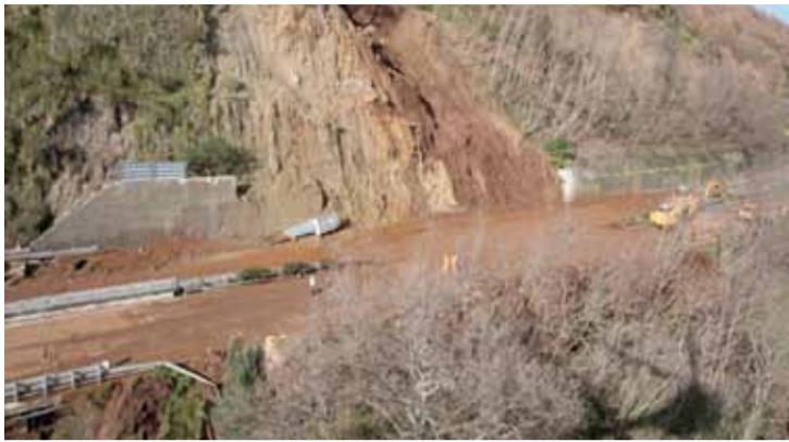
La frana del 25 gennaio 2009 sulla A3, che ha provocato due vittime
