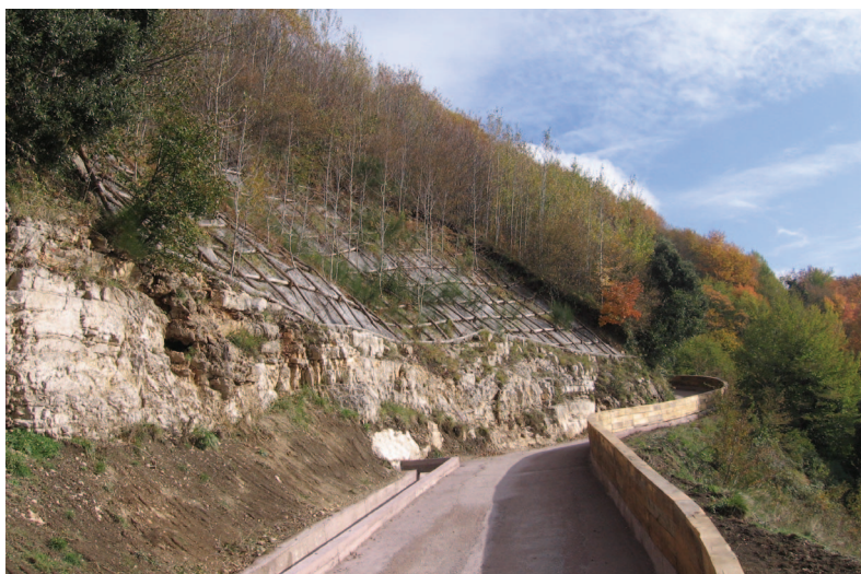
Interventi con tecniche di ingegneria naturalistica sui versanti di Episcopio, nella parte alta del Vallone Tuoro
