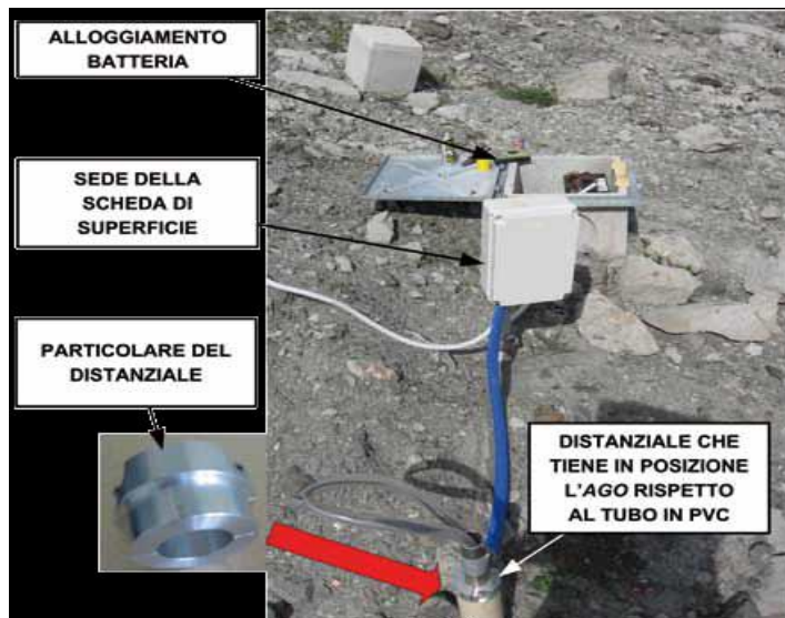
Figura 54. Immagine che mostra come appare un blocco di misura dopo l'installazione. È possibile vedere: l'alloggiamento della batteria; il contenitore che racchiude la scheda di superficie; il tubo in PVC (arancione) dentro cui è inserito l'ago, mantenuto in posizione da un distanziale.
