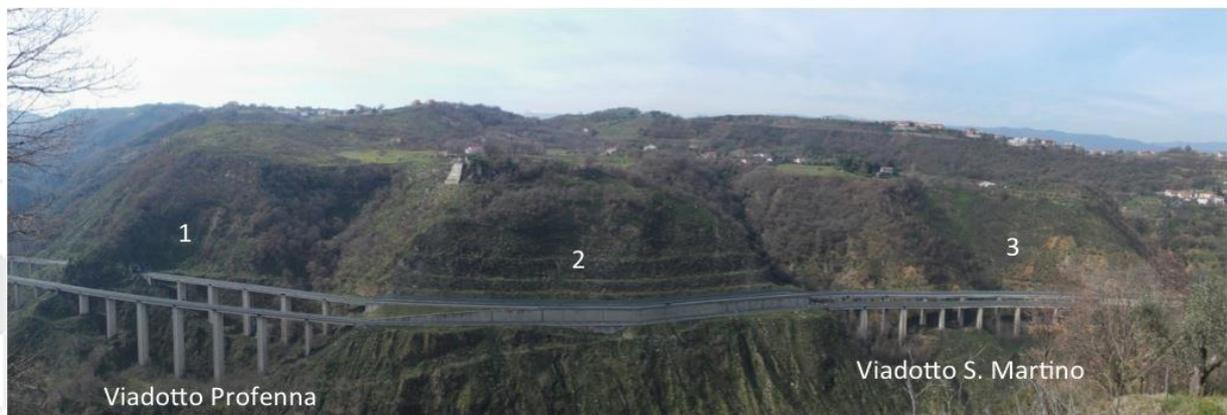
*Figura 59. Vista dal punto di installazione dello strumento selezionato per la sperimentazione. Il dissesto numero 1 (sul viadotto Profenna al km 263.3) è lo stesso visibile in Figura 38 mentre il numero 3 (sul viadotto San Martino, al km 262.5) è osservabile in Figura 36 e Figura 37.*
