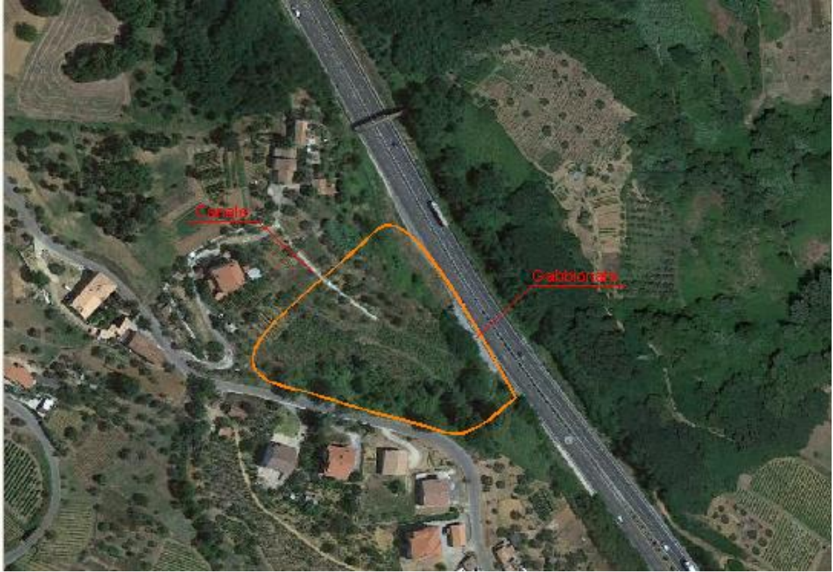
A3, UGM 2 - FIEGO: delimitazione della frana ed opere di difesa esistenti
