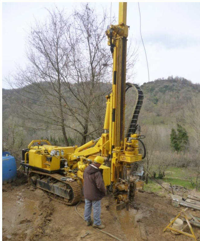
A3, UGM1 – Esecuzione delle perforazioni
