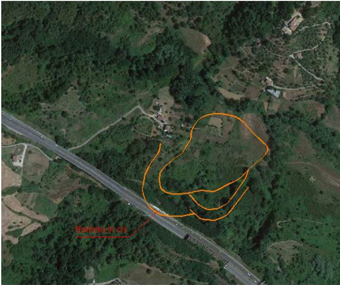
A3, UGM 1 - MANCARELLI: delimitazione della frana ed opere di difesa esistenti
