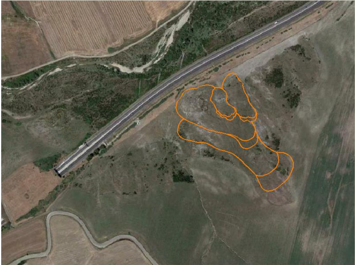
A16, UGM 1 – km 112+350: delimitazione della frana ed opere di difesa esistenti
