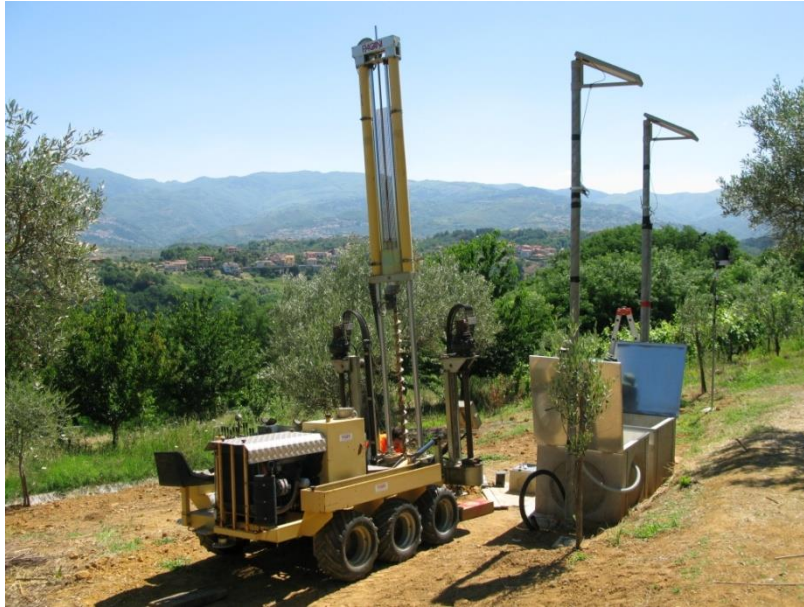
A3, UGM2: esecuzione delle perforazioni per l'alloggiamento dei tensiometri
