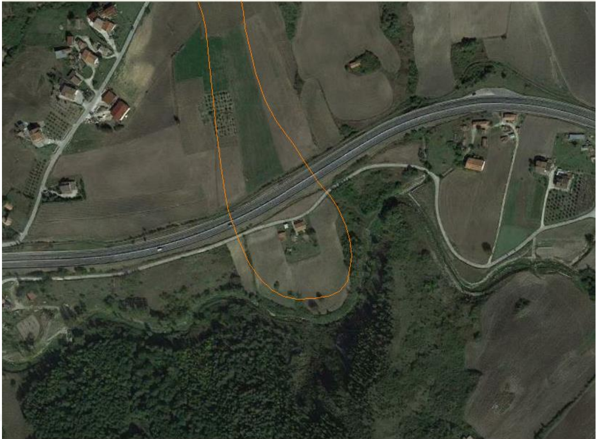
A16, km 97+450: delimitazione della frana ed opere di difesa esistenti
