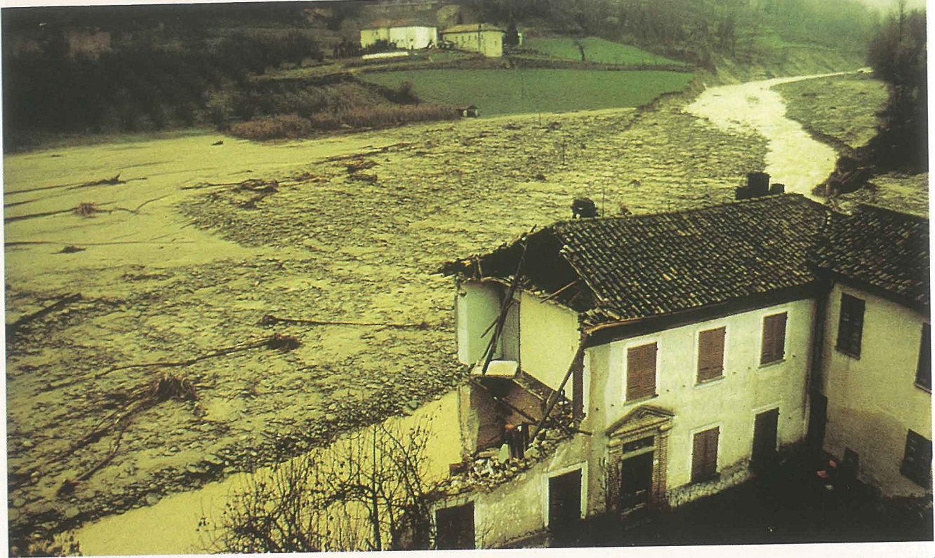
Valle Belbo, località Campetto (Bosia). Profonde erosioni laterali, coinvolgenti anche porzioni di versante, hanno causato parziali distruzioni di edifici. (Archivio IRPI-Torino)
